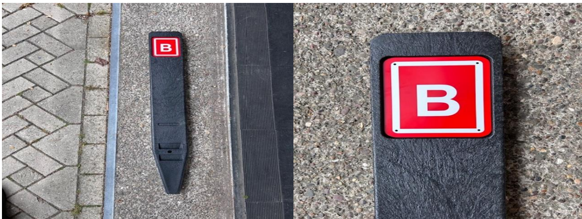
Figuur 6: Herkenbaarheidsbord “inlaatpunt brandweer”
